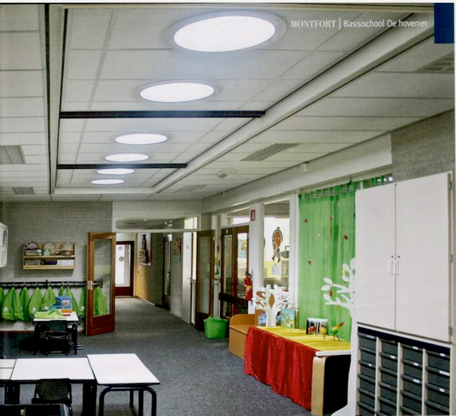
Zes Lightway daglichtsystemen vervangen een lichtstraat (27m 2 ), waarvan de contouren nog zichtbaar zijn.
