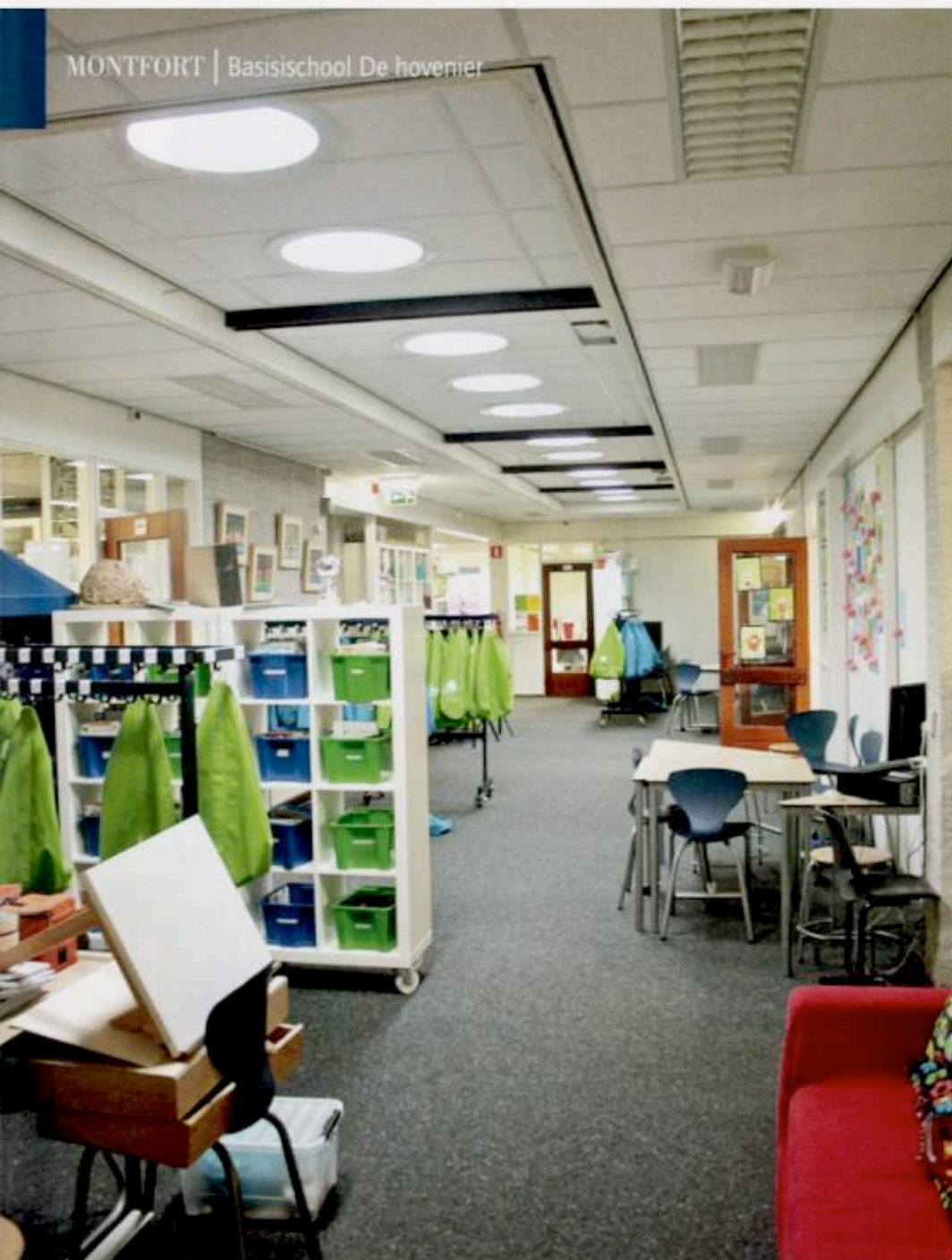
In de tweede hal van de Hovenier hangen elf Lightway 600HP ter vervanging van een lichtstraat van 35m 2 , een halvering in investeringskosten.
